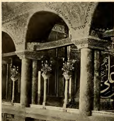
Fig. 101 — Loggiato superiore della basilica di Santa Sofia a Costantinopoli (a. 532-537)
